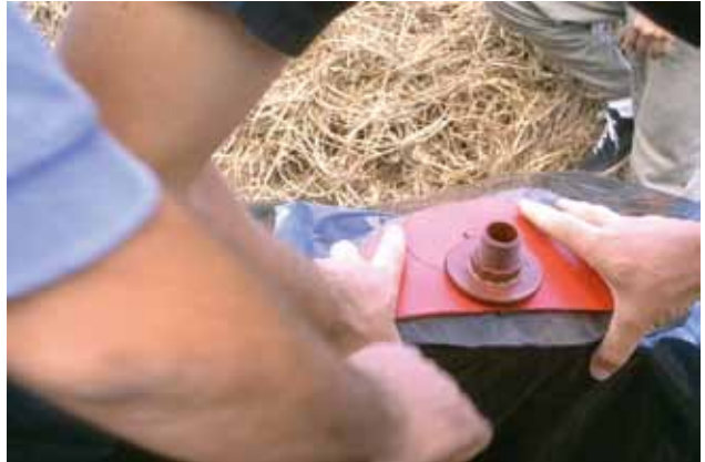
Figura 5: Colocación válvula de salida de biogás. Predio de Miguel Lechini
