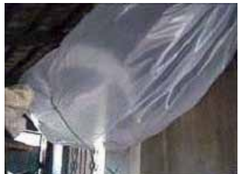
Bolsa colgada del techo para almacenamiento de biogás.
