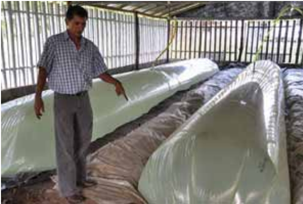
Biodigestores en serie.
