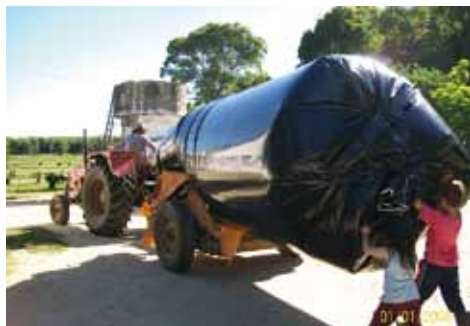
Inflado de biodigestor con escape de tractor. Predio del Sr. Guzmán González. Castillos. Rocha
