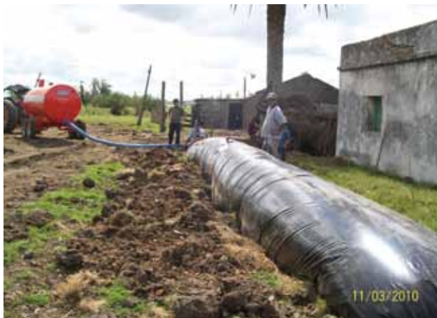
Inflado de biodigestor. Predio del Sr. Justo Bonilla. San Ramón. Canelones
