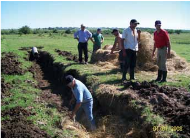
Construcción de biodigestor en predio de Fredy Chury, San Ramón, Canelones.
