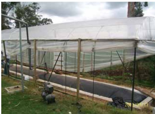
Biodigester con protección (macrotúnel) Parque Ute-Antel (Lavalleja)
