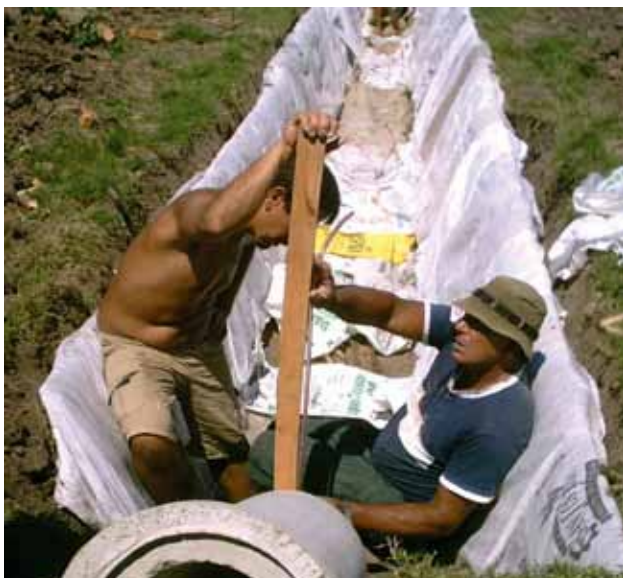
Utilización del nivel de agua. Instalación de biodigestor en predio del Sr. Barboza, Treinta y Tres.
