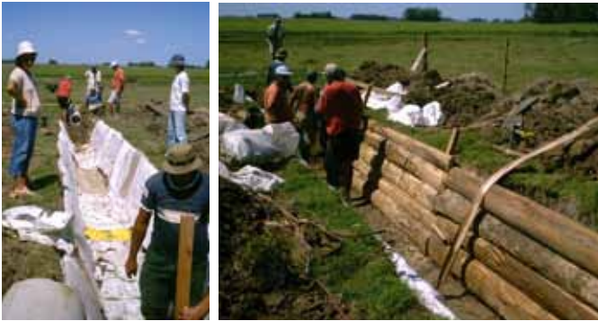
Construcción de biodigestor en el predio del Sr. Barboza, Treinta y Tres.
