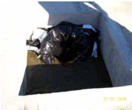
Cámara para realizar la mezcla de estiércol y agua. Predio de Guzmán González. Castillos. Rocha
