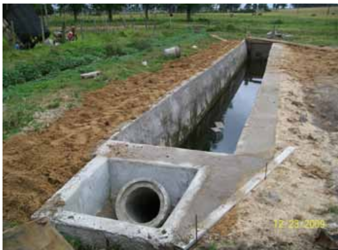
Instalación de biodigestor en predio de Guzmán González, Castillos, Rocha.
