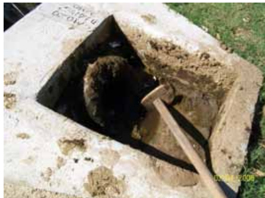
Cámara para realizar la mezcla de estiércol y agua. Predio de Guzmán González. Castillos. Rocha
