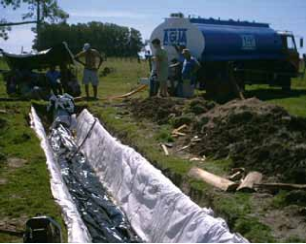
Llenado de la bolsa con agua. Predio del Sr. Barboza, Treinta y Tres.
