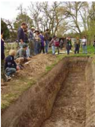
Fosa para biodigestor Escuela Agraria de Libertad.
