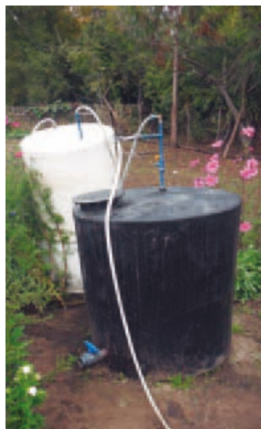
Módulo de biodigestor y estanque para el almacenamiento del biogás. Aprovecha los desechos orgánicos, genera un combustible limpio para uso en la cocina y contribuye al ahorro de leña.
