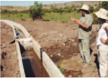
Obras construidas como parte de los planes de desarrollo elaborados e implementados por las comunidades agrícolas.
