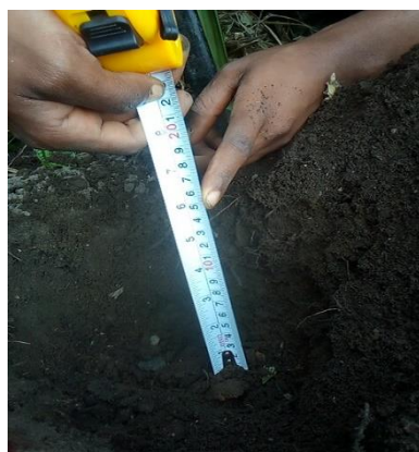
Tranchée de 20cm creusée pour la plantation du vétiver
