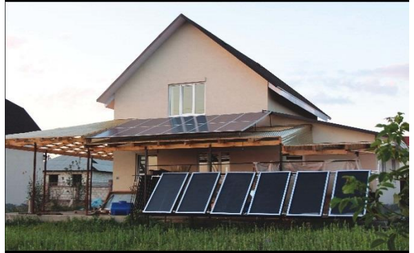
Tehnologiile ecologice inovatoare – colectoare solare pentru încălzirea apei, instalate în Primul Centru Ecologic de Inovații Sociale, (s. Țarigrad, r. Drochia)
