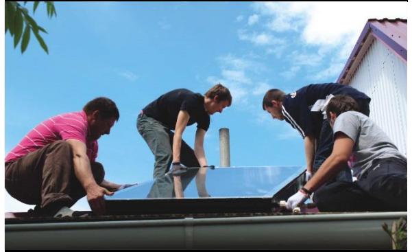
Instalarea colectoare solare pentru încălzirea apei în Muzeul Femeierului (s. Cotova, r. Drochia)
