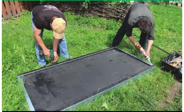
Pregătirea colectoarelor solare pentru încălzirea apei
