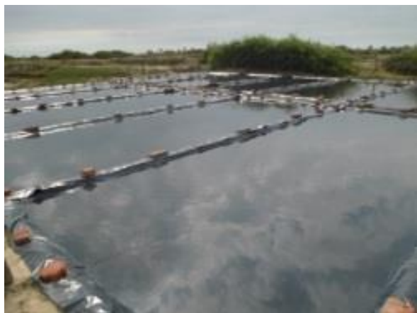
Foto 3: Eras salineras con geomembranas
