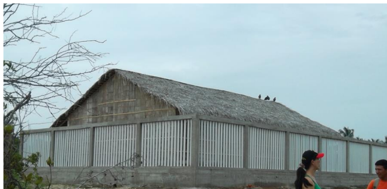
Foto 5: Centro de acopio y procesamiento en Las Gilces
