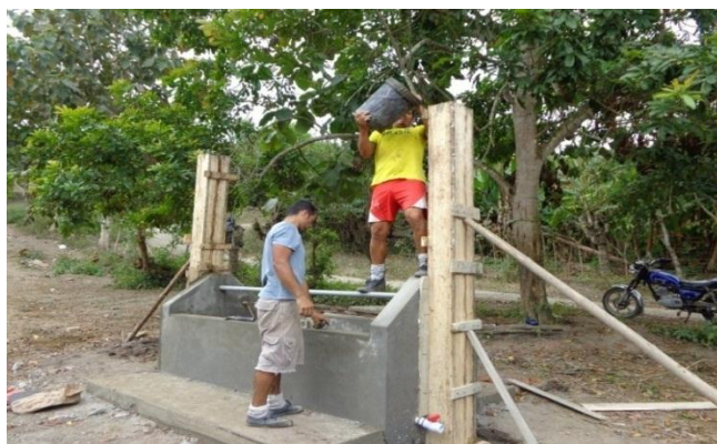
Construcción de bebedero de agua en la comunidad Piquigua
