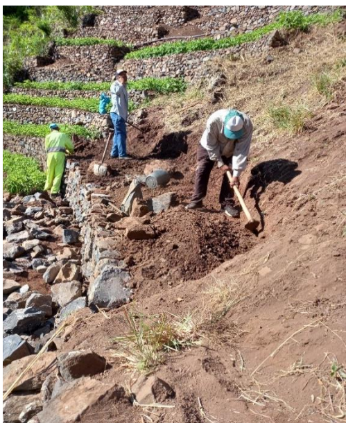
Foto 5 – Construção de arretos em Fragata
