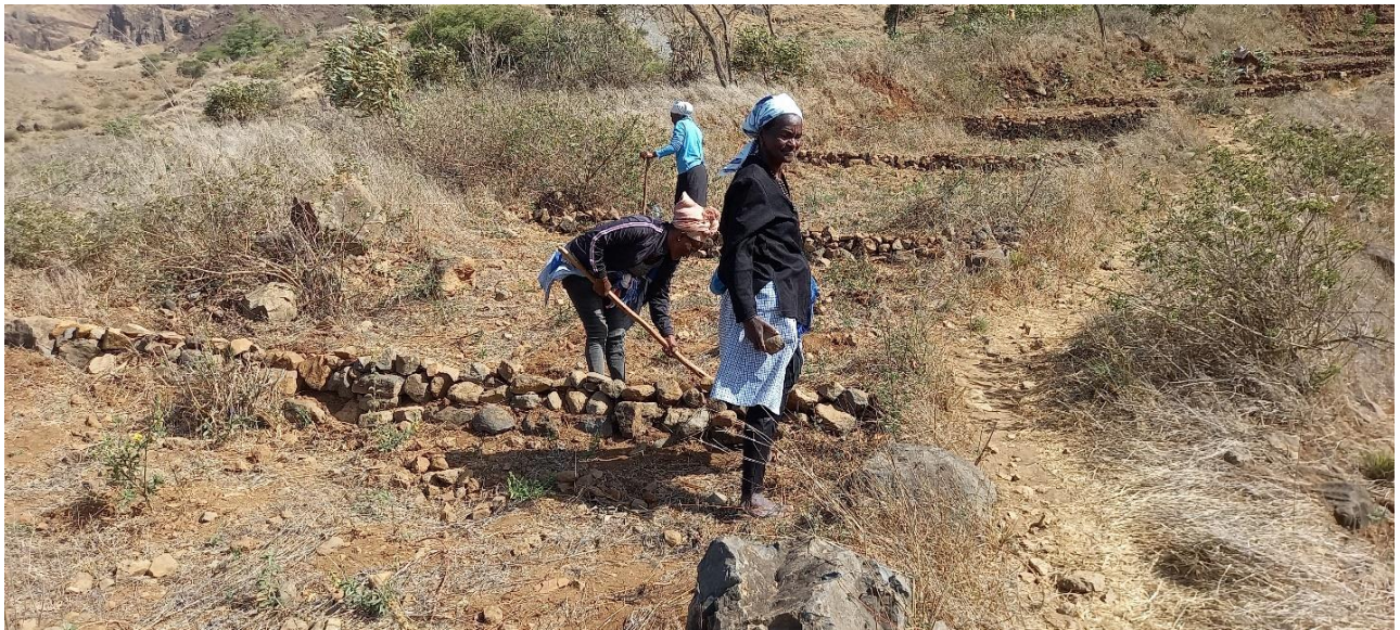
Foto 9 – Construção de arretos em Fundura, Santiago
