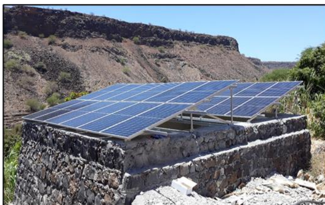
Foto 1 – Reservatório reabilitado com cobertura de painéis solares
