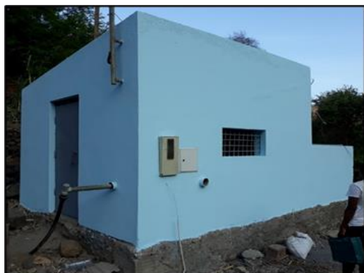
Foto 2 – Casa de abrigo dos equipamentos reabilitada
